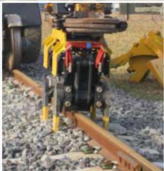
Stabiles Trassenbett mit dem RST Schotterverdichter
