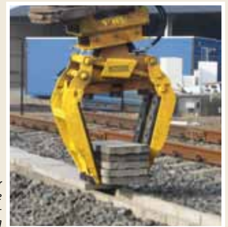
Der GRL Greifer erleichtert die Kabelschacht-abdeckung
