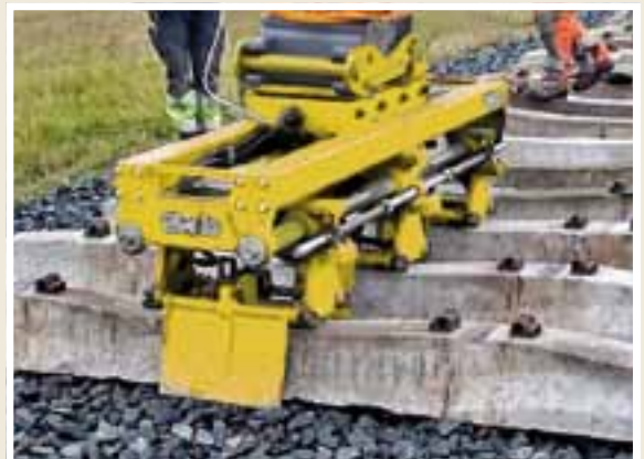
Der RUS Bahnschwellenleger positioniert mehrere Schwellen gleichzeitig
