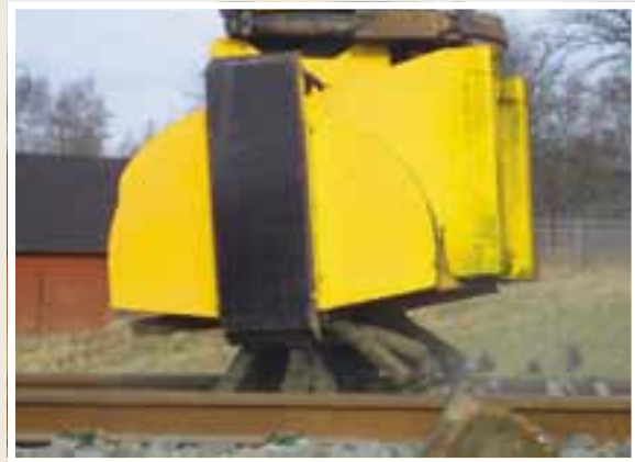
Nivellieren und Verteilen von überschüssigem Schotter? SKB-Ballast!
