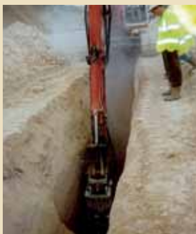
Kanal- und Rohrleitungsbau
